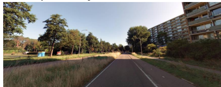
Figuur 2.4: Boerhaavelaan (oostbaan) met fietspaden in twee richtingen direct naast de rijbaan
