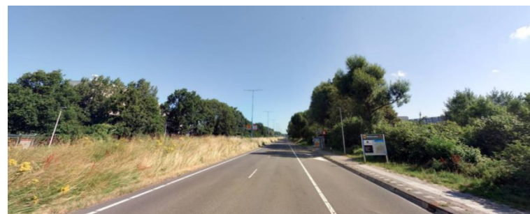
Figuur 2.2: De Afrikaweg (oostbaan) met busbaan en halte
